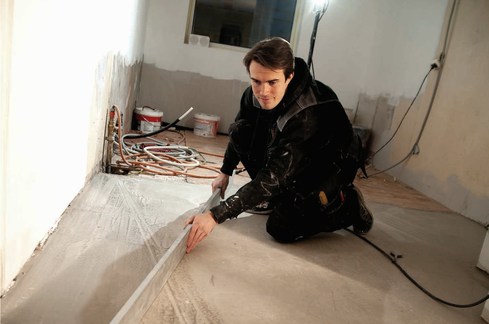
Under oppussingen får byggingeniøren, som til daglig jobber hos Multiconsult, omsette teori til praksis. Her sjekker Krister Bjørnbak at avrettingen av golvet endte ut i vater.
